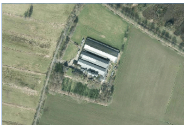
Luchtfoto huidige situatie
