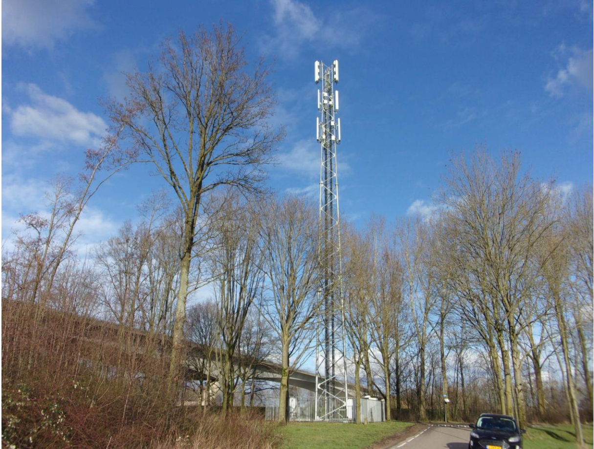
Voorbeeld vrijstaande zendmast met antennes van drie mobiele operators
